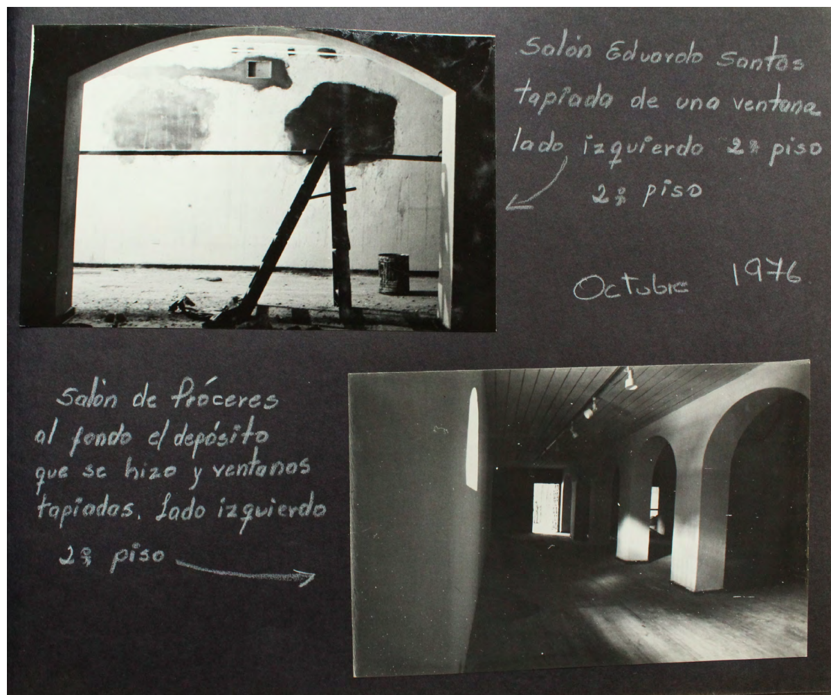
Fig. 3 Autor desconocido Salón de próceres, al fondo el depósito que se hizo y ventanas tapiadas. Lado izquierdo
